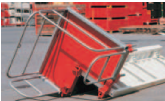
Valamisplatvorm kinnitatakse juba maapinnal raketise külge.
