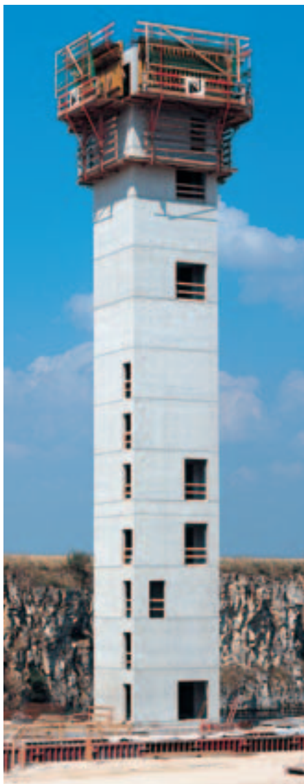
43,50 m kõrge tööstusettevõtte torn laudise tekstuuriga dekoratiivse betoonpinna.
