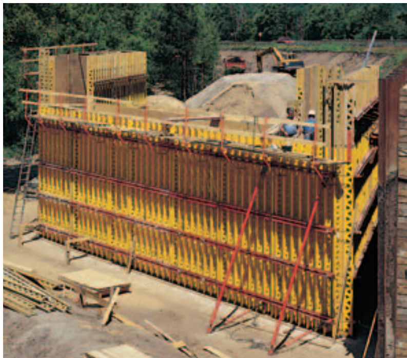
Sillasammas VARIO standardkilpidega. Teede mitmetasandiline ristumiskoht BAB 24 kiirteel Wittstockis Saksamaal.
