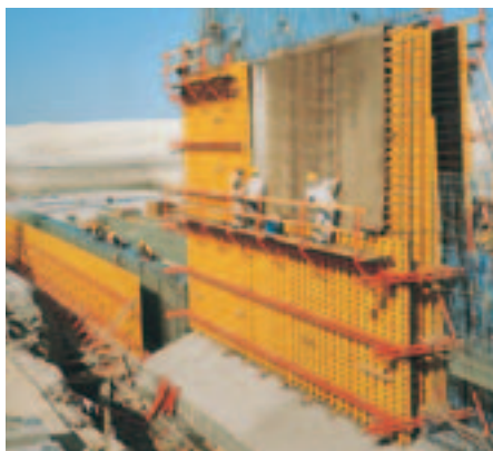
VARIO GT 24 kasutamine set-tebasseini muutuva ristlõikega seinte ehitamisel Koreas.
