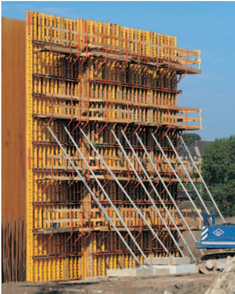
10,7 m kõrgused seinad raketatud kaks korda jätkat- tud VARIO raketisega
