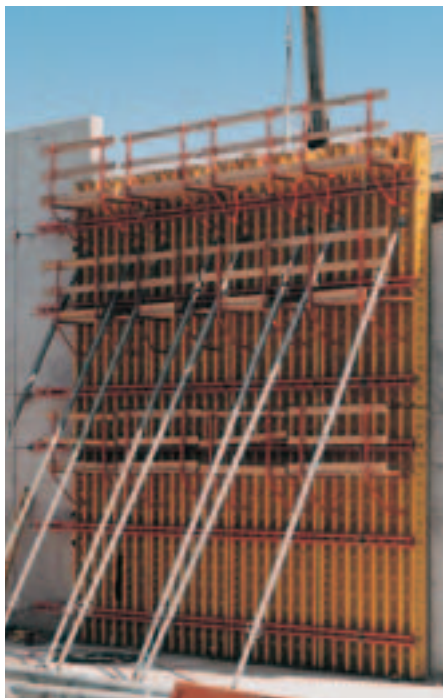
Pikendatud VARIO kilpide kasutamine büroohoone raketises.
