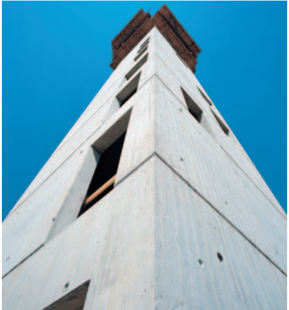
Püstlaudise koreda tekstuuriga atraktiivne betoonpind.
