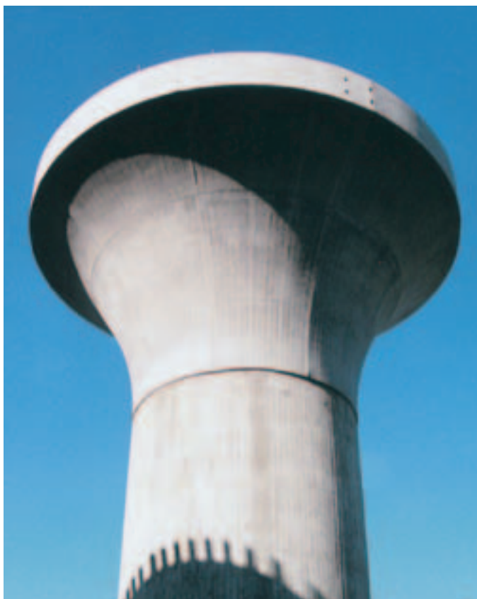
BAB 4 kiirteesild üle Triebischbachi oru Saksaamaal. 49 m kõrgused ringjoonelise ristlõikega ja leetri kujulise peaosaga sambad.
