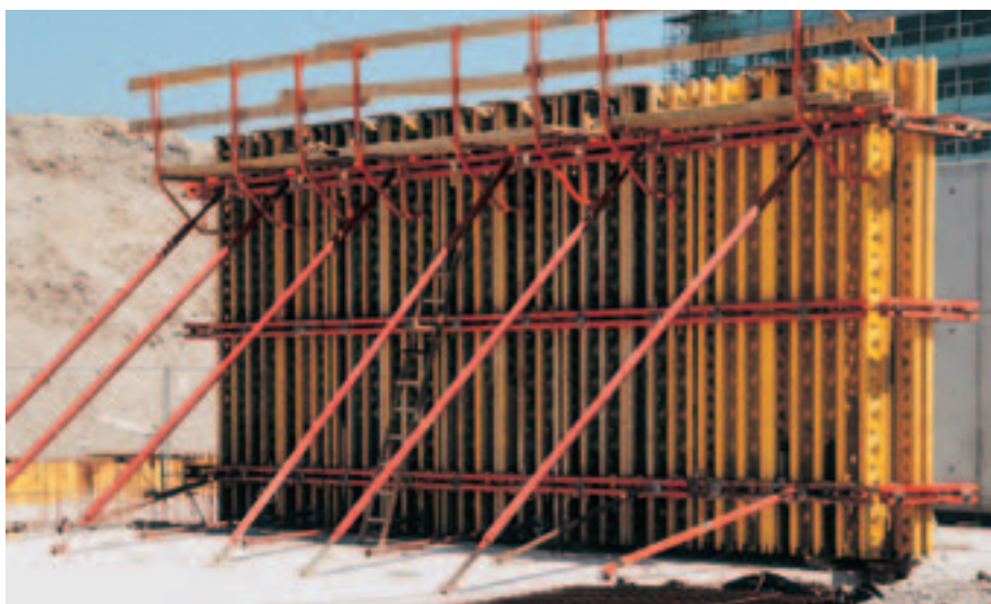
4,20 m kõrgune VARIO otsa- lõpetusega raketis
