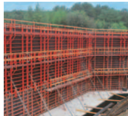
TRIO kasutamine tööstusehitise ehitamisel.
