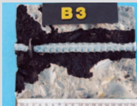
... sissebetoneeritud tõmbi ümber seavad ohtu veekindluse.
