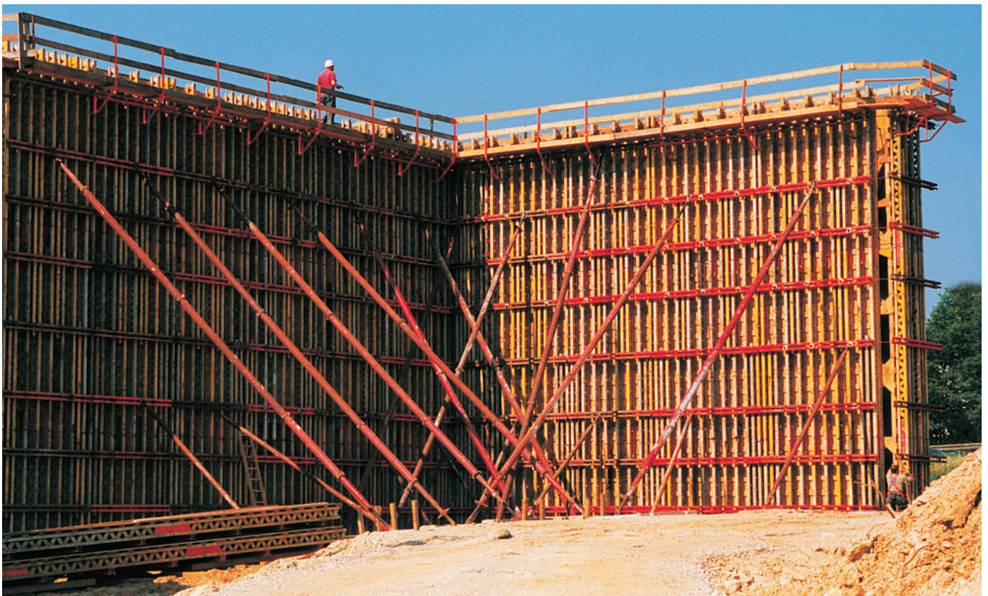
11,00 m kõrguse sillasamba raketis.
