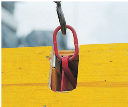
Betooni eest kaitsev pealmine kattelaud ning kilbi külge kinnitatud tõsteaas.
