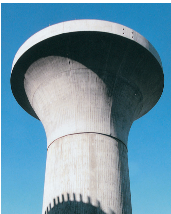
BAB 4 kiirteesild üle Triebischbachi oru Sak-samaal. 49 m kõrgused ringjoonelise ristlõikega ja lehtri kujulise peaosaga sambad.
