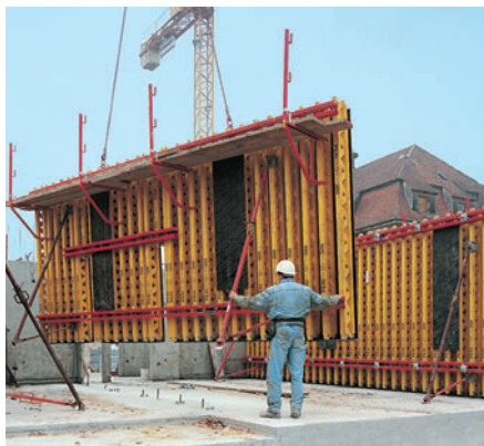
VARIO GT 24 kasutamine eramu ehitamisel.
