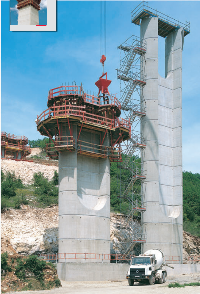
Kiirteeviadukt Prantsusmaal. Erandliku betoonpinna ja keeruka geometriaga sambad. Ühepoolne raketis VARIO GT 24 ja platvormid SKS.
