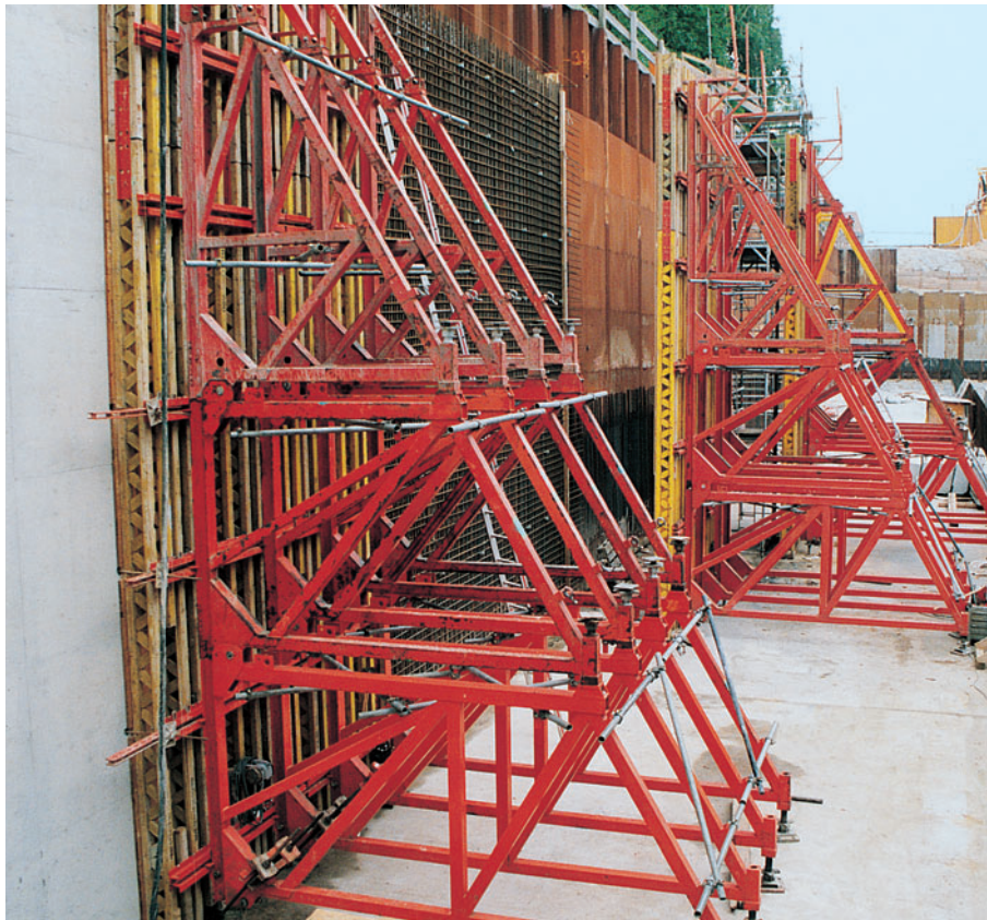
Maksimaalne valukõrgus 8,75 m A0, A, B või C tugiraami ja VARIO GT 24 raketisega.
