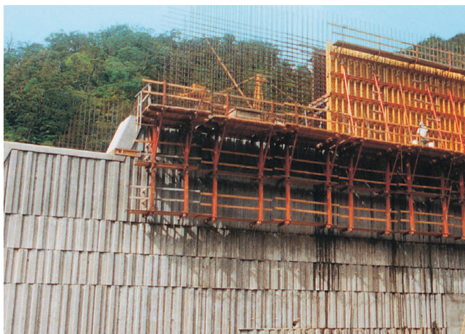
Tunneliportaal Havail. VARIO GT 24 raketis ronisüsteemi KGF 240 kohal.
