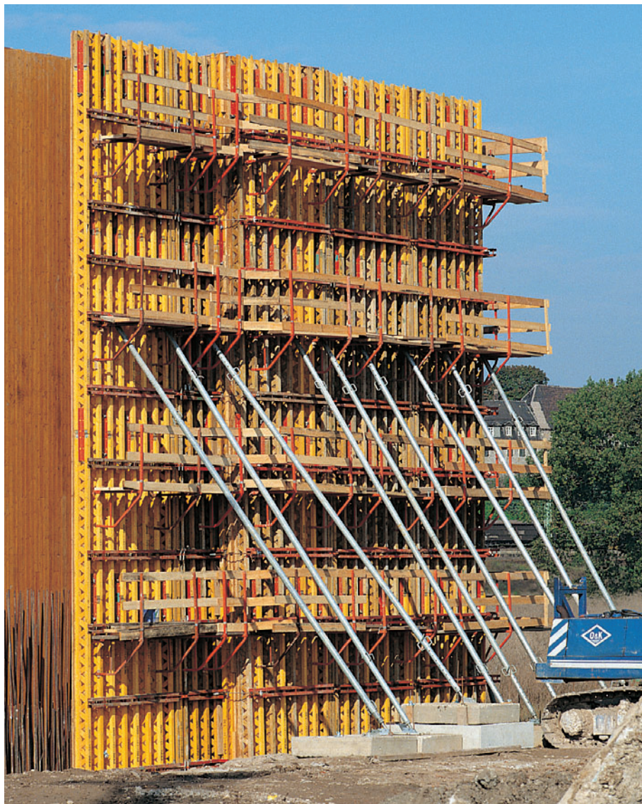
10,7 m kõrgused seinad raketatud kaks korda jätkatud VARIO raketisega
