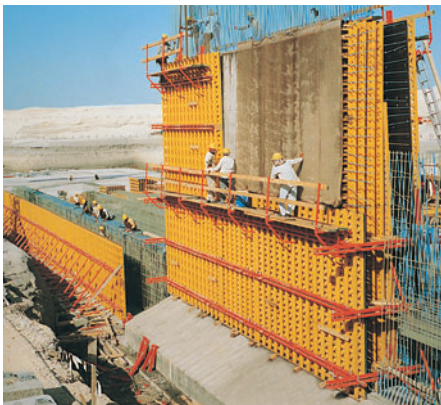
VARIO GT 24 kasutamine setebasseini muutuva ristlõikega seinte ehitamisel Koreas.
