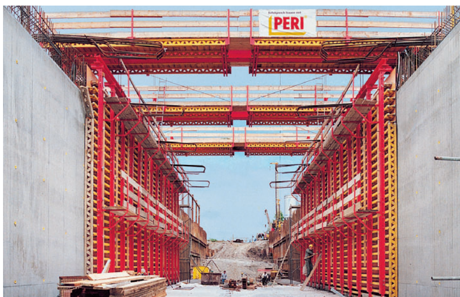
Tunnel B 311 maantee läbimiseks Ertingen, Saksamaa.
