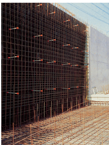
Häggsviksledeni Tunnel, Rootsi
