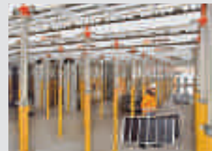
Опалубка для перекрытий
