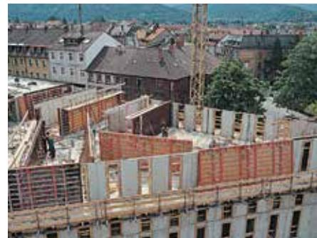
TRIO Structure – это вариант проверенной системы рамной опалубки, который может использоваться с полным набором дополнительных приспособлений TRIO.
