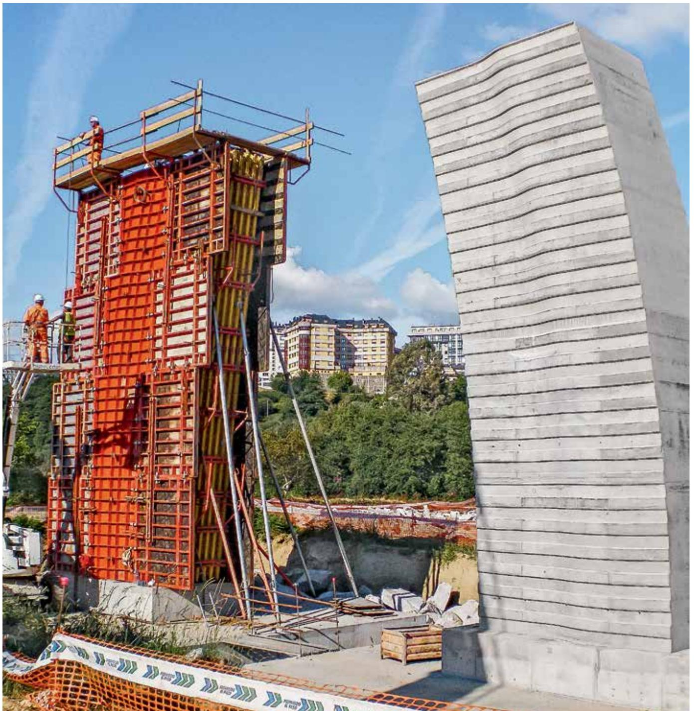
TRIO Structure, которая используется для формирования промежуточной мостовой опоры: покрываясь дополнительными деревянными планками, в результате, обеспечивает интересную структуру поверхности.
