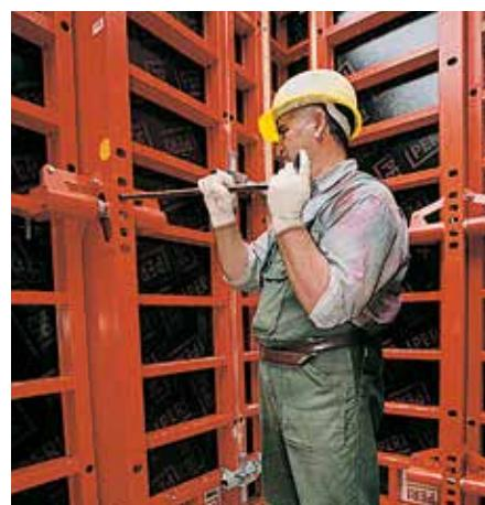
При распалубке, стропы крана крепятся ко всем четырем шахтным элементам, а опалубочный элемент устанавливается в распалубочном положении с помощью рычажной системы.
