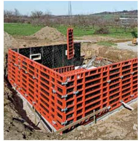
Несколько различных компонентов системы, а также универсальный выпрямляющий замок BFD - который можно устанавливать одной рукой - обеспечивают быструю и легкую установку опалубки TRIO
