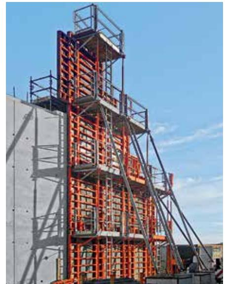
Оснащенная соответствующими системами рабочих платформ, стеновая опалубка TRIO обеспечивает максимальную безопасность для строительной команды. Завершенные, крупногабаритные подвижные установки с рабочими платформами, лестницами и ограждениями могут перемещаться от одного цикла к другому.
