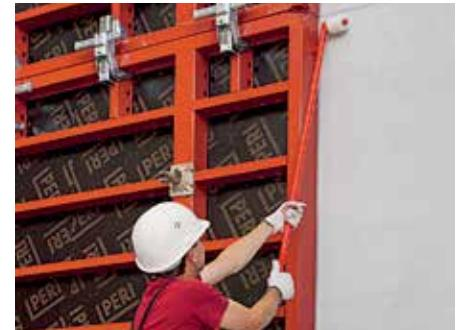
Используя стержень для распалубки, панели можно снять легко и без повреждений. Направляющий ролик также предотвращает повреждение бетонной стены.
