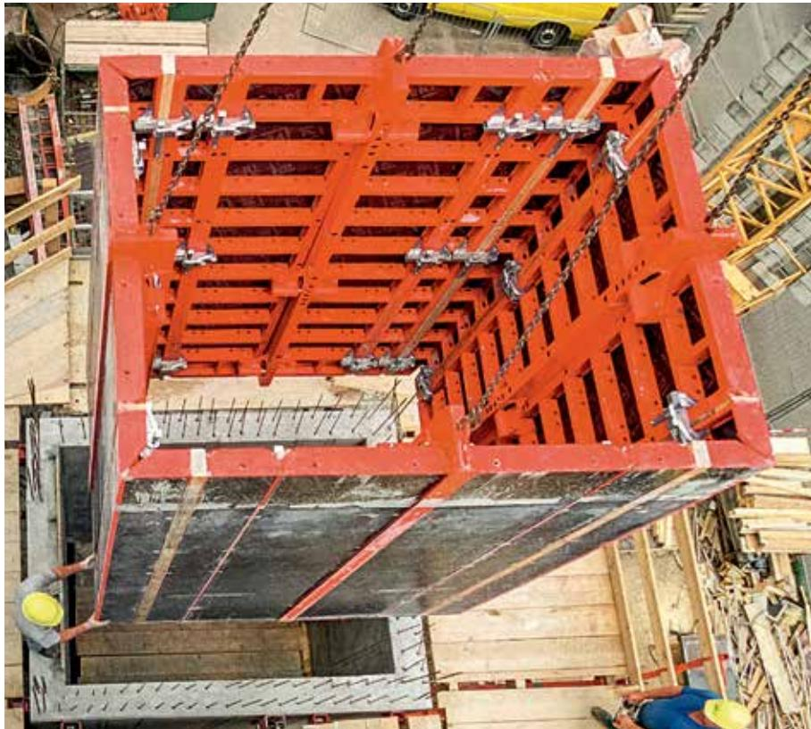
Для прямоугольных шахт нужны регулируемые крановые стропы в связи с разной длиной точек крепления. Это приводит к приблизительно одинаковому усилию растяжения на всех четырех стропах.
