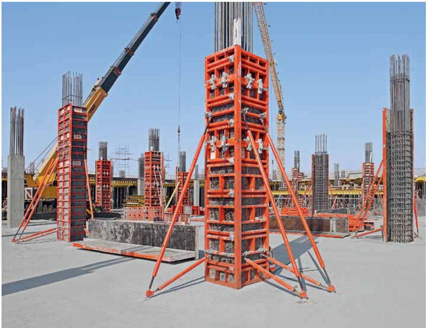
Колонны можно построить, используя 3 высоты, с наращиванием по 30 см. Замки BFD соединяют элементы колонны при расширении.
