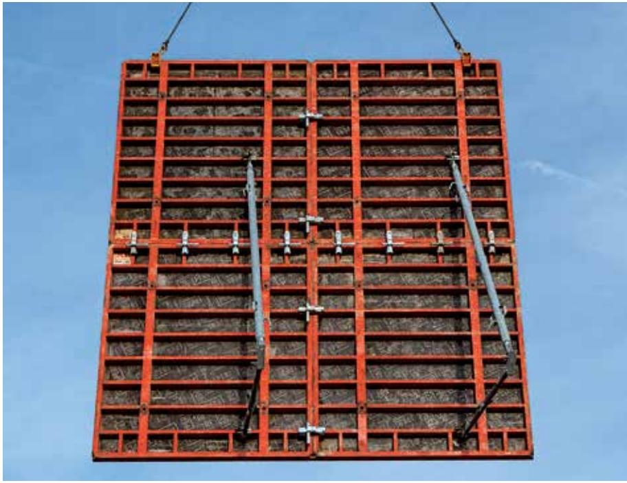
Для расширений до 5,40 м в высоту, требуется только один выпрямляющий замок BFD благодаря кольцевым стойкам.
