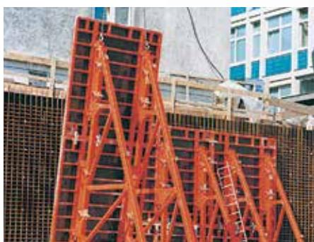
Крепление производится с силовым замыканием, что позволяет перемещение смонтированных единиц в комплекте.
