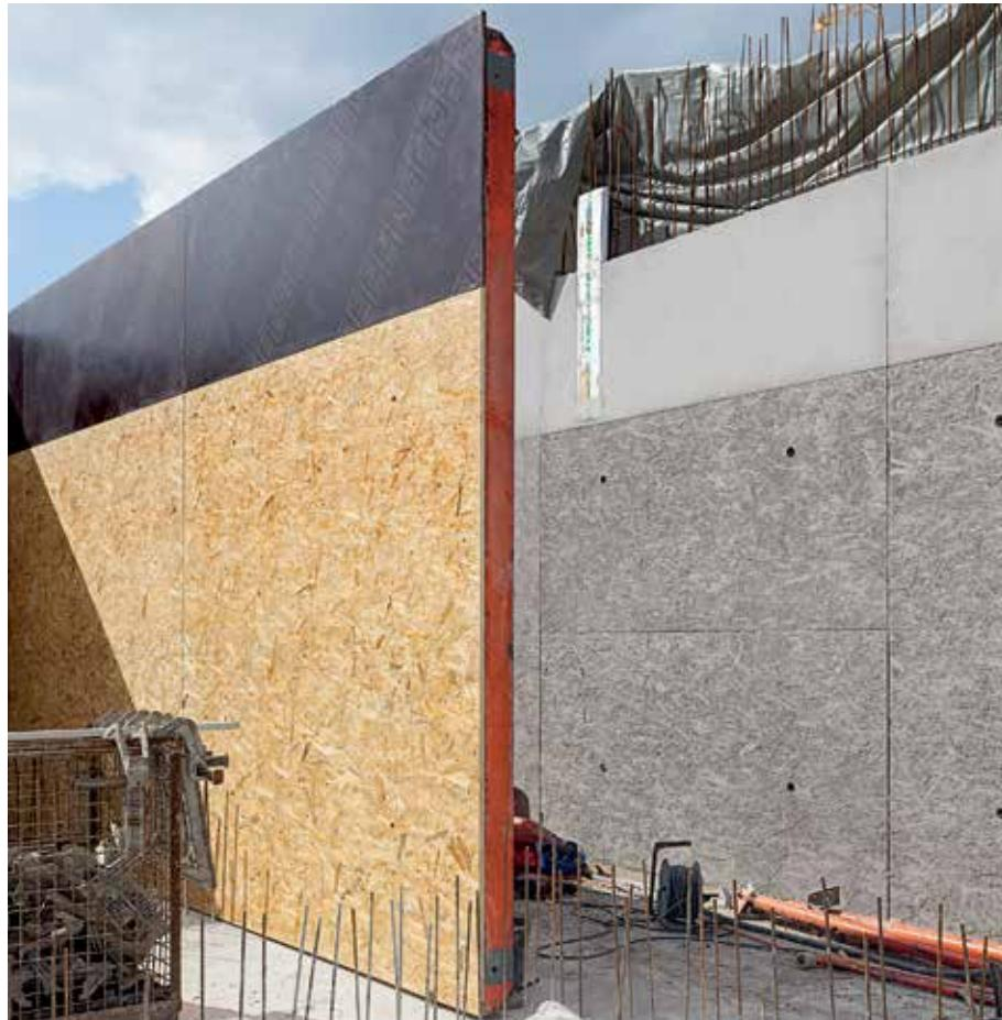
С TRIO Structure, архитектурные конкретные требования SB 3 выполняются в полном объеме. Листы ОСП и обшивка опалубки FinPly аккуратно устанавливаются с тыльной стороны.
