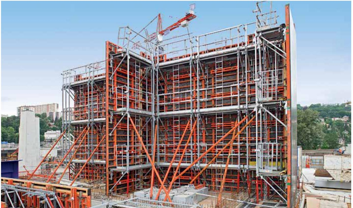
**Система платформ MXR обеспечивает максимальную безопасность благодаря своей уникальной конструкции. Удобно выбранные размеры платформы гарантируют эффективную работу.**
