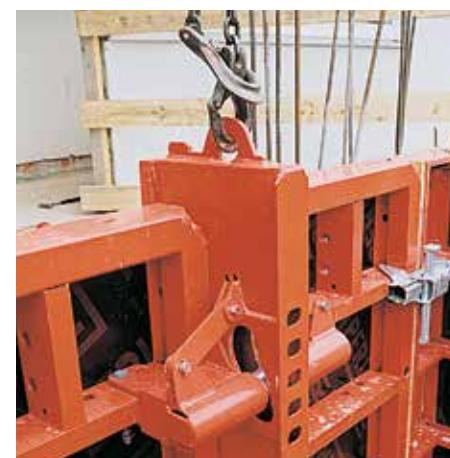
После подъема с помощью крана, шахтный элемент TSE освобождается, что приводит к образованию необходимого зазора распалубки.
