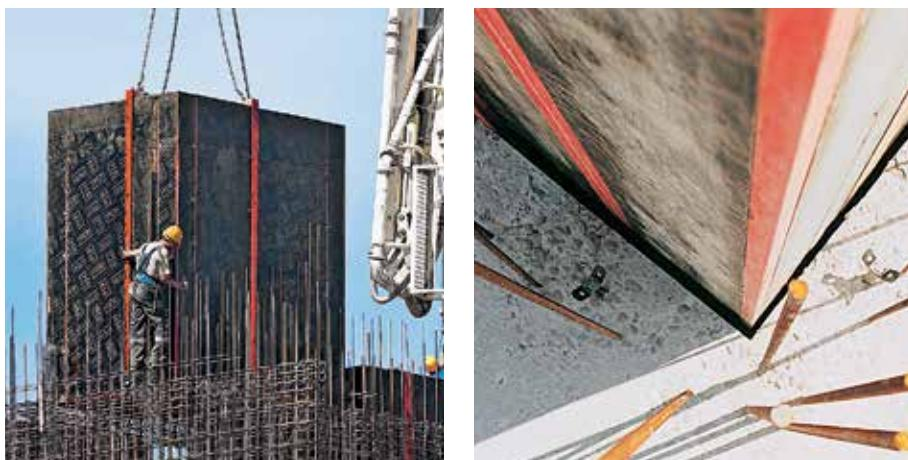
При извлечении шахтных элементов, на каждой стороне обеспечивается зазор распалубки отчетливо виден. Сам шахтный элемент остается возле бетона, таким образом, обеспечивая лучшее направление.
