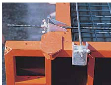
Подвеска для тяжей позволяет выполнить крепление без сетки за пределами элемента. Именно поэтому она используется для создания фундаментов и наращивания элементов.
