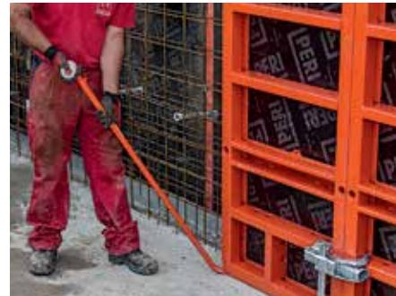
С помощью выравнивающего уголка можно достичь точного положения панели, без применения молотка. Это особенно просто, если вы используете стержни для распалубки.
