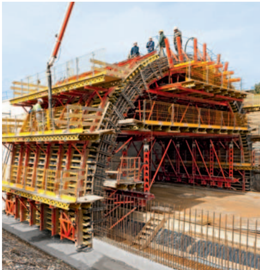
PROKIT EP 110 tagab ohutuse kõikidel selle tunneli raketise lahtistel äärtel.
